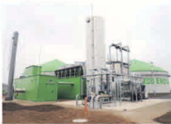
Die Bio-Erdgas-Anlage im brandenburgischen Schwedt.
